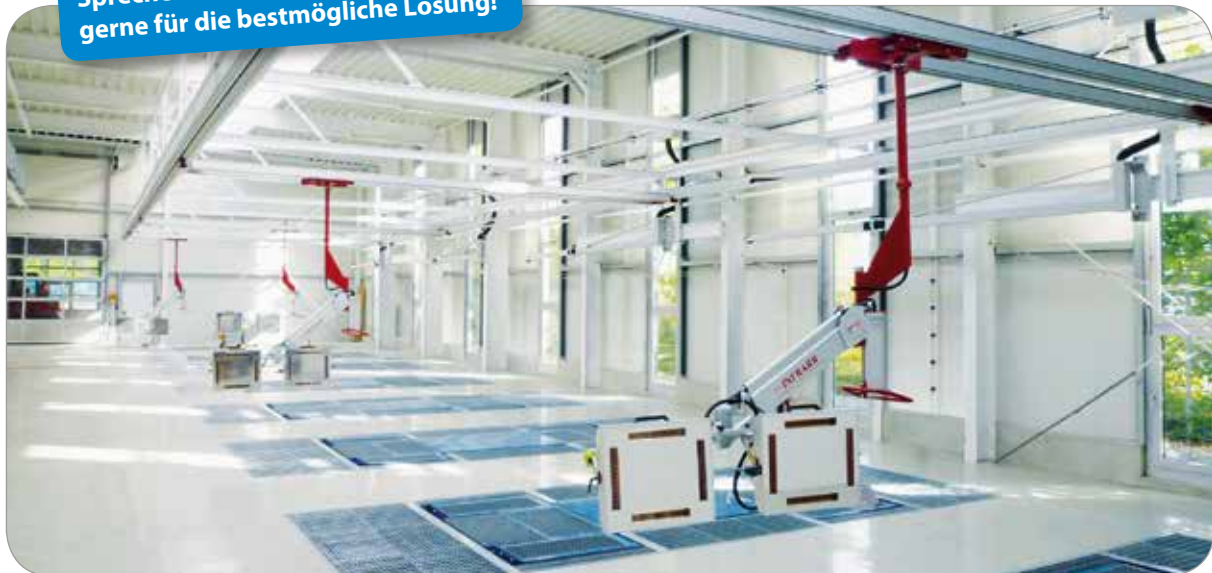
Autohaus Filser GmbH, 88471 Laupheim: INFRARR IR-Schienensystem und CAV Schleifstaub-Absauganlage
